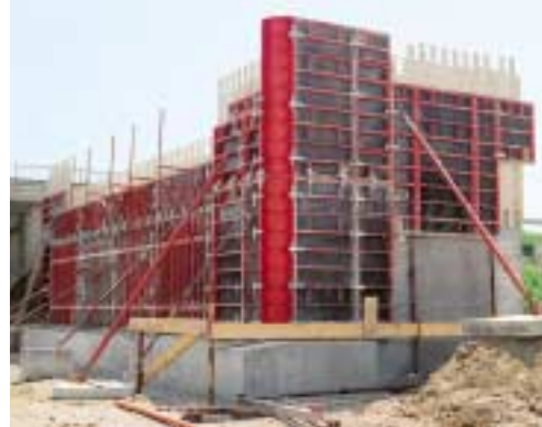
Spalla sulla B30 nei pressi di Laupheim; cassaforma a telaio TRIO rivestita con tavoli in legno. Impresa: Reisch, Saulgau, Germania
