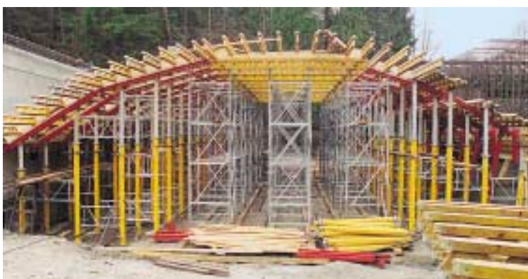
Impalcatura di sostegno della cassaforma per un ponte ad arco a tre campate. Boemia, Repubblica Ceca.
