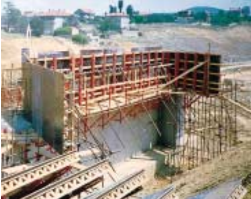
Spalla del ponte sull'autostrada del Bosforo. Cassaforma a ripresa SKS. Impresa: Consorzio IGL-STFA
