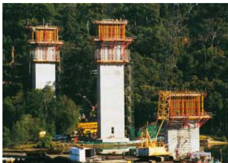
Cassaforma a ripresa: VARIO GT 24 e TRIO con sistema CB e piattaforme di ripresa BR.
