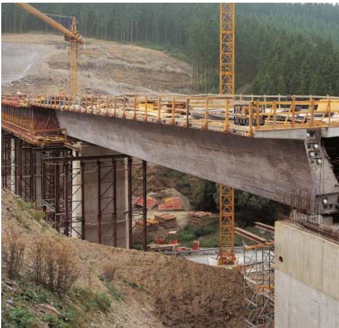
Gettati fondo e fianchi, la cassaforma interna delle anime viene rimossa e si procede al montaggio della cassaforma della soletta superiore, composta dalla sovrastruttura del sistema MULTIFLEX GT 24 montata su tavoli MULTIPROP.
