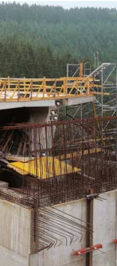
Ultimata la 1° campata, di lunghezza 53 m dell'impalcato a sezione scatolare.
