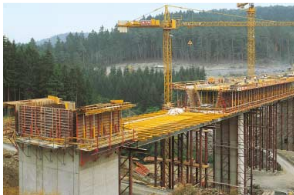
La 2° campata in fase di getto. L'ultima ciclo di ripresa delle spalle realizzate con TRIO.
