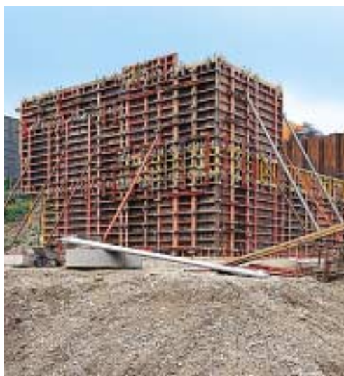
Spalla realizzata con cassaforma TRIO.
