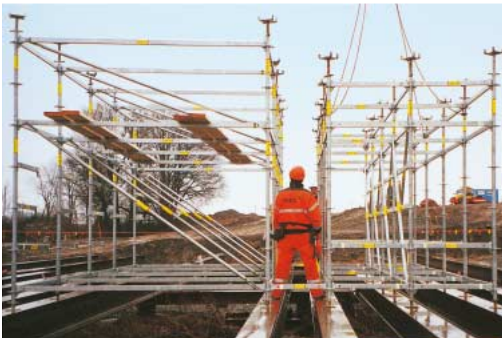
Posizionamento della seconda unità. Il corrente orizzontale PERI UP UH deve solo essere inserito nel nodo Rosett.
