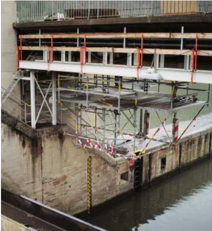
Impalcatura sospesa sul fiume Neckar a Hessigheim, Germania.
