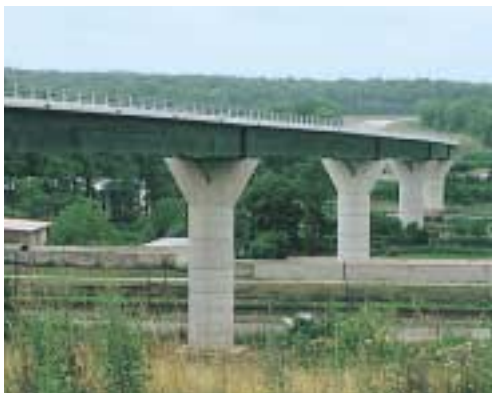
Ponte a travata, Viadotto di Marnaval, RN 67, St. Dizier, Francia
