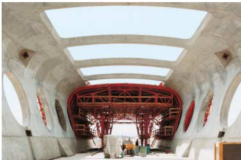
Foto del ponte-galleria simile a una scultura, durante i lavori.
