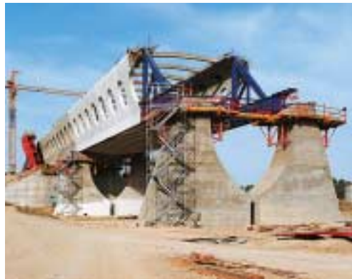
Foto dal sotto della sovrastruttura. Per controllare la procedura di scivolamento, tipica del metodo di costruzione di ponti per estrusione, è stato necessario posizionare sulle teste pile delle piattaforme di servizio con mensole di ripresa KG 240 e travi GT 24.
