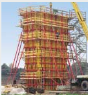
Cassaforma della pila, realizzata con VARIO GT 24 a travi, preassemblata presso il centro servizi PERI e consegnata in cantiere. Ponte sul Saale, Weissenfels, Germania.
