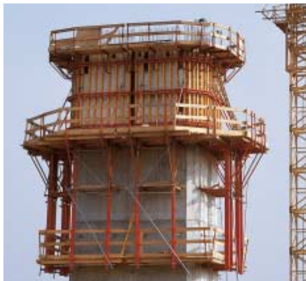
Dimensioni accurate e perfetta qualità superficiale del cls. Le pile sono state realizzate con la cassaforma a ripresa VARIO GT 24 abbinata alle passerelle KG.
