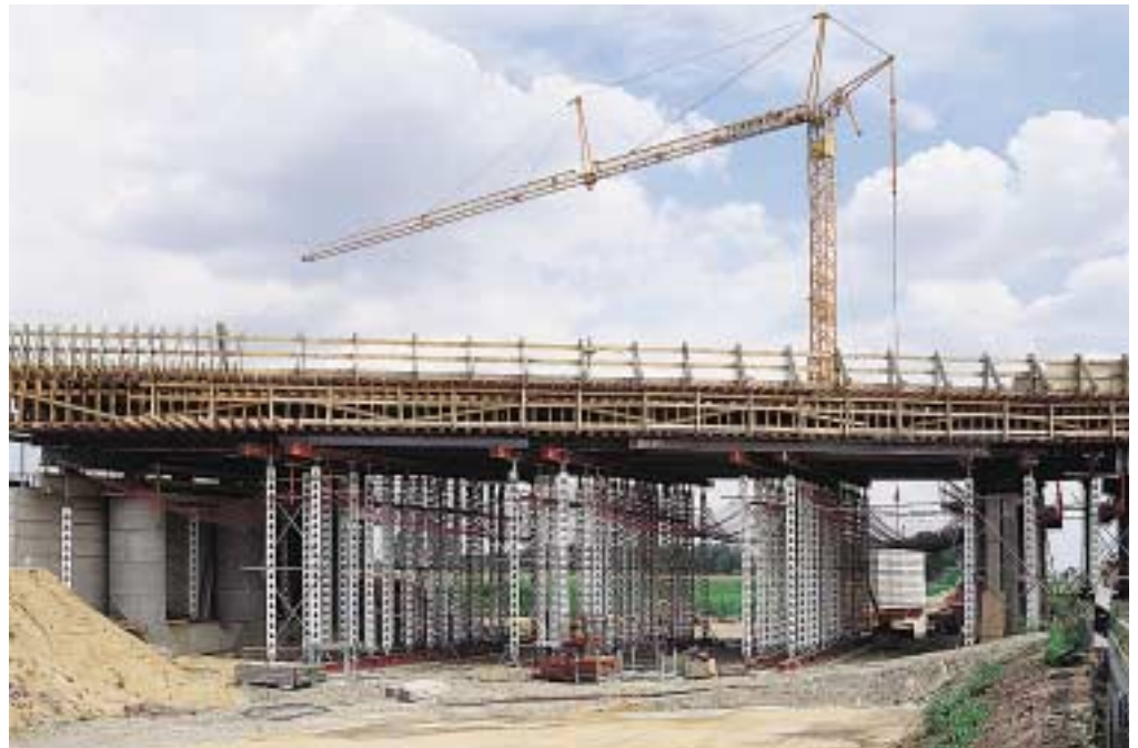
Impalcatura di sostegno alta 75 m realizzata con il sistema PERI HD 200 per un viadotto a due campate sulla BAB A2, Germania.
