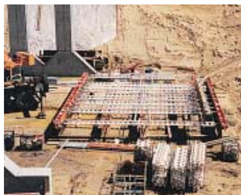
Preassemblaggio di unità di stilate di puntoni realizzate con componenti di serie PERI HD 200, quali le travi d'orditura e segmenti di puntoni per carichi elevati.
