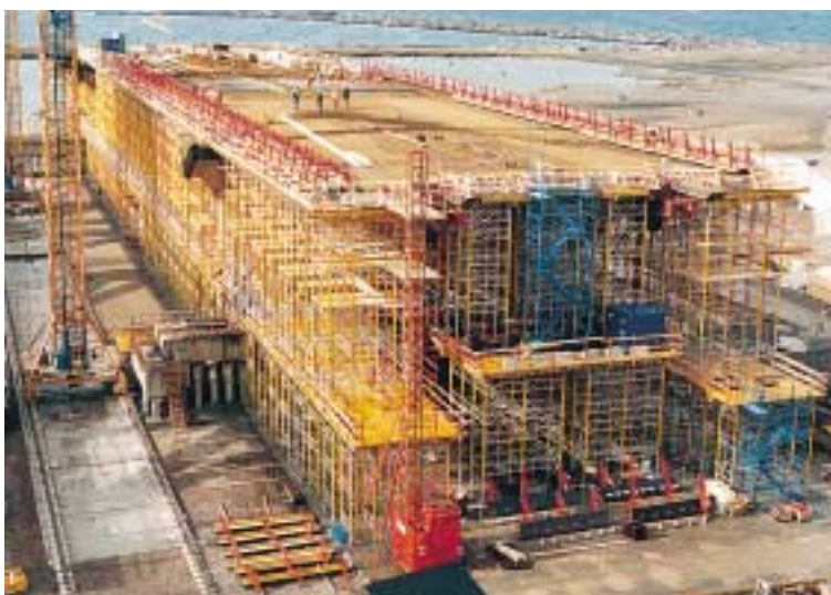
Impalcatura di sostegno alta oltre 16 m, realizzata con MULTIPROP per le solette di un impalcato in acciaio e c.a. collaborante, con campate di 120-160 m, che costituiscono gli elementi strutturali del ponte lungo 1.092 m sullo stretto di Oeresund.
