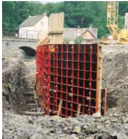
Muri andatoi svincolo della B15 nei pressi di Hagen. Cassaforma a telaio HANDSET. Impresa: Köster, Hagen, Germania
