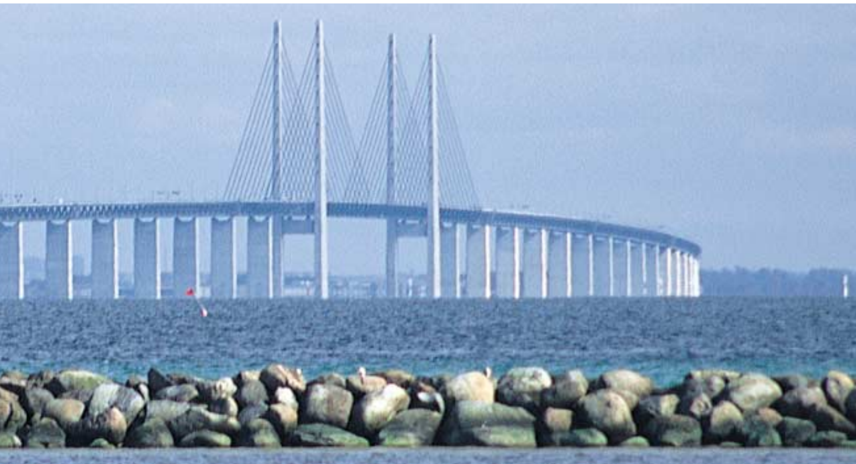
Il ponte di Oeresund tra Svezia e Danimarca è costituito da una carreggiata con quattro corsie.
