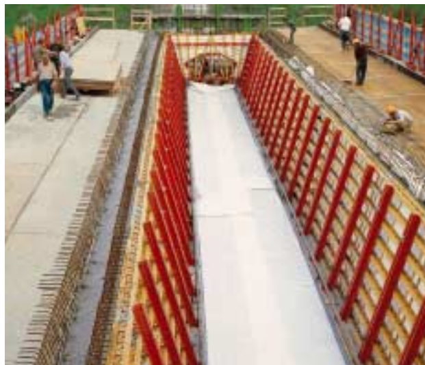
Tronconi di sezione scatolare (1° fase di getto). In attesa di disarmare la cassaforma interna dell'anima, si prepara la cassaforma della soletta a sbalzo per la posa del ferro d'armatura.
