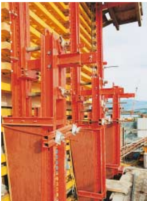
La struttura di sospensione e di movimentazione per la parte inclinata.
