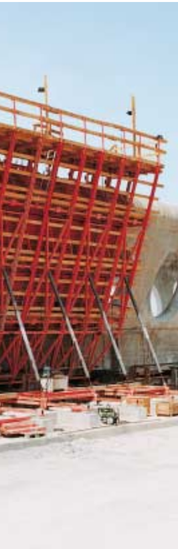
Foto dal sotto della sovrastruttura. Per controllare la procedura di scivolamento, tipica del metodo di costruzione di ponti per estrusione, è stato necessario posizionare sulle teste pile delle piattaforme di servizio con mensole di ripresa KG 240 e travi GT 24.
