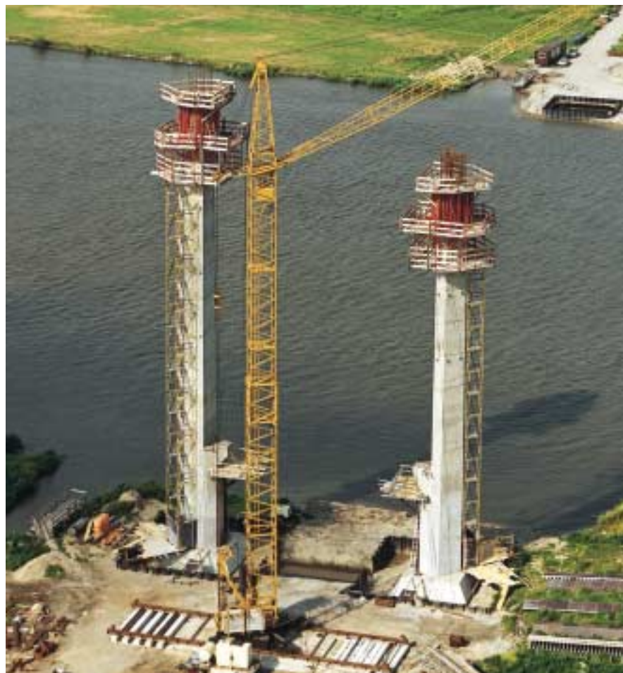
Cassaforma a ripresa PERI per pile con forma geometrica complessa. Ponte sospeso di Deltjssel, Kampen, Olanda.
