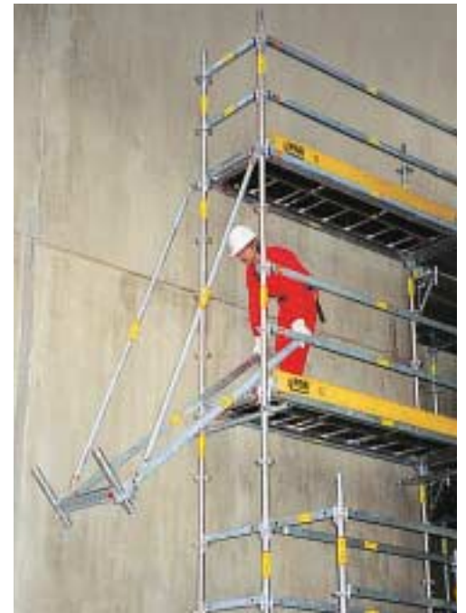
Montaggio di uno sbalzo con una diagonale tra nodi.
