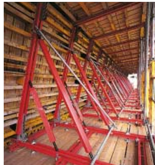
Le travi PERI GT 24, i correnti PERI SRZ, i montanti PERI MULTIPROP e i puntoni di regolazione formano la cassaforma esterna dell'impalcato.
