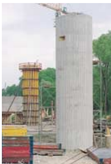
Pila con ottima finitura superficiale del cls a vista, con impronte delle tavole in legno.
