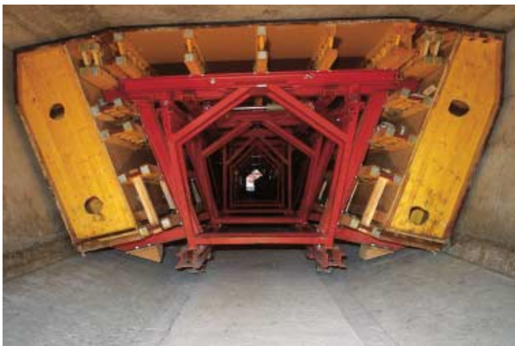
Sulla cassaforma interna sono state collocate delle sagome, per conformarsi alla sezione interna dell'impalcato.
