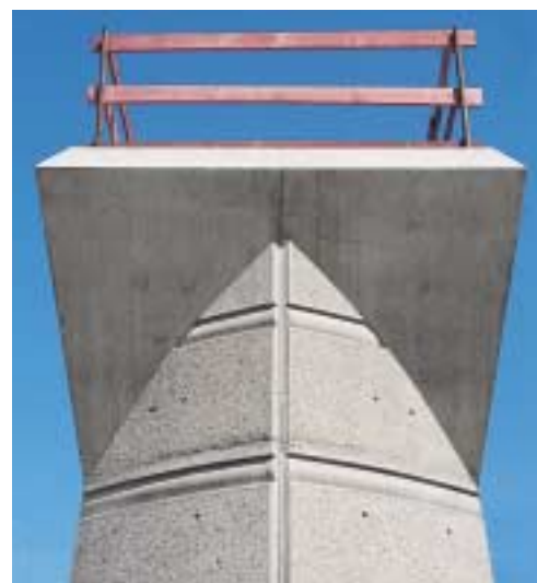
Pila con forma geometrica particolare e finitura superficiale del cls a vista.
