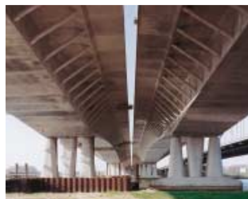
Vista da sotto del ponte, con i due impalcati in parallelo, dove verranno realizzate le corsie stradali.
