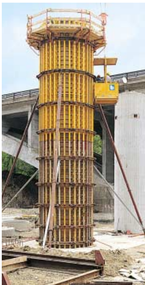
Le pile cilindriche monolitiche sulle sponde del fiume con diametro di 2,5 m sono state costruite impiegando correnti con snodo GRV e travi reticolari GT 24. E' stato così possibile evitare tiranti d'ancoraggio che comportano notevoli costi. La cassaforma preassemblata è stata poi posizionata in cantiere mediante gru.
