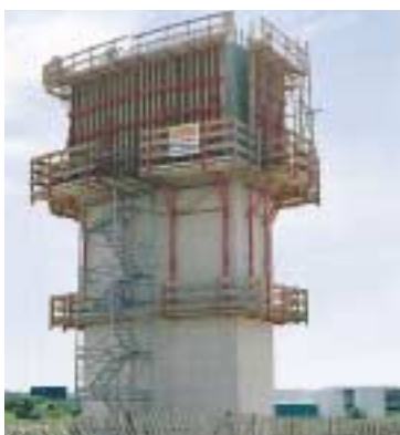
Accesso sicuro con le scale a torre PD 8 per gli addetti del cantiere.
