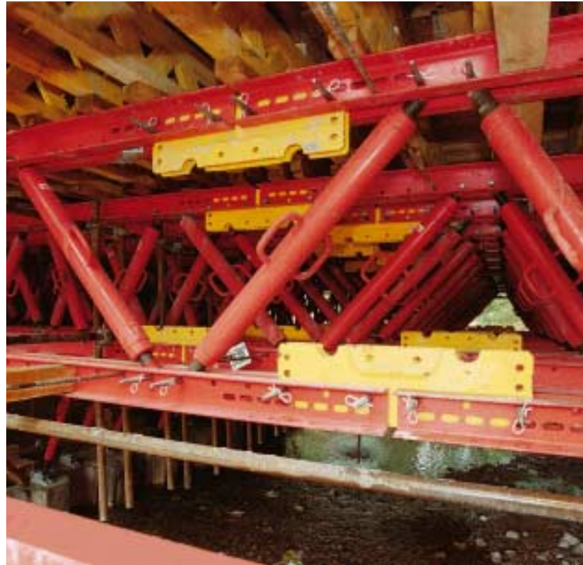
La giunzione universale UK 70 collega i correnti metallici universali SRU inferiori e superiori della travatura reticolare.
