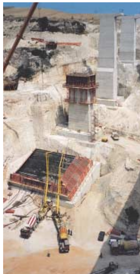
Cassaforma per le fondazioni degli archi del Ponte Santa Lucia, Italia.
