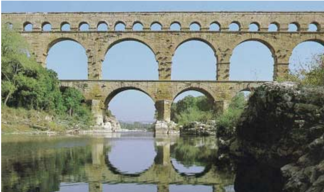
A Pont du Gard, nei pressi di Nîmes, in Francia, è possibile ammirare un acquedotto alto 50 m con luce di 269 m, costituito da tre ordini di arcate semicircolari in pietra e conglomerati (19 d.C.).
