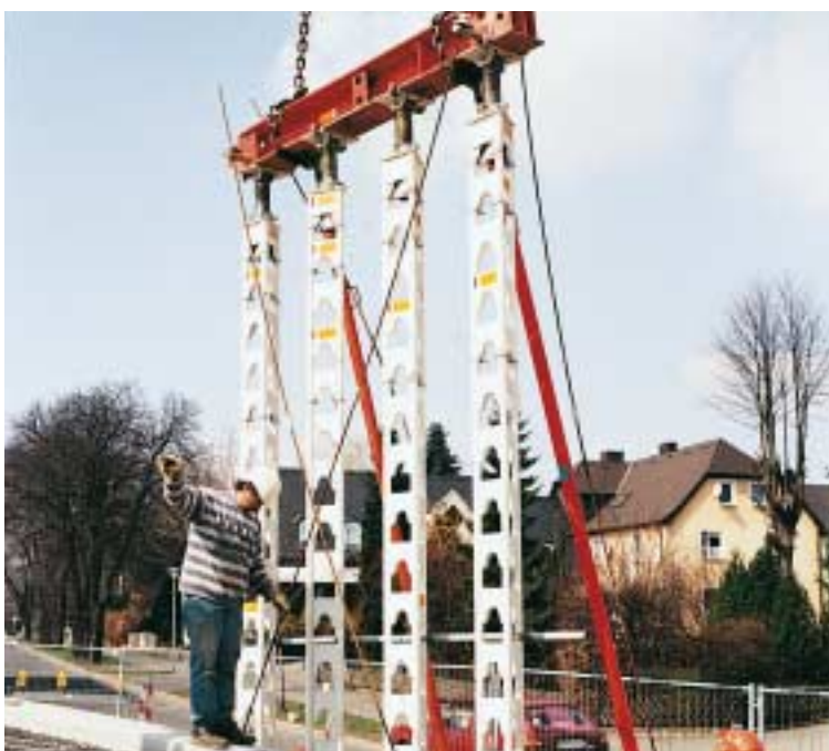
Sollevamento con gru di stilate di puntellazione preassemblate.
