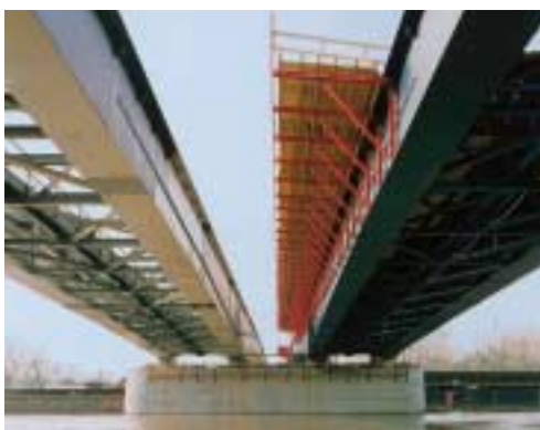
Le pile si ergono dal letto del fiume e supportano la sovrastruttura a due carreggiate del ponte.
