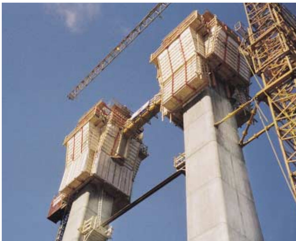
Cassaforma a ripresa autosollevante PERI ACS con quattro impalcati di servizio: passerella di servizio, passerella di ripresa,
