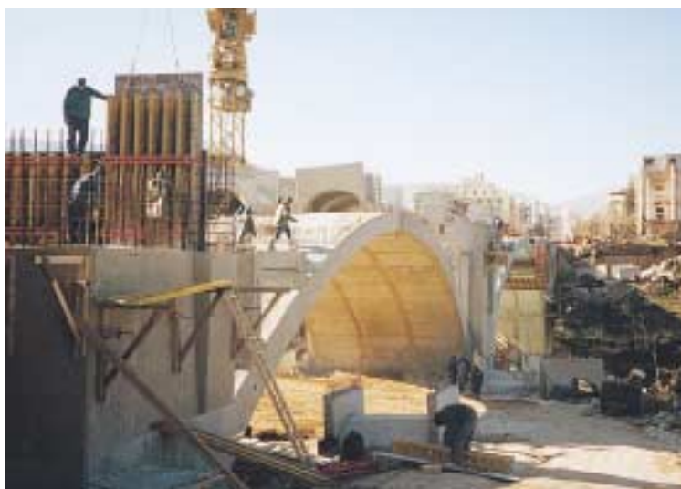
Spalla del ponte realizzata con VARIO, appoggiato su mensola SKS
