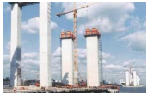
Accesso sicuro con le scale a torre PD 8 per gli addetti del cantiere.
