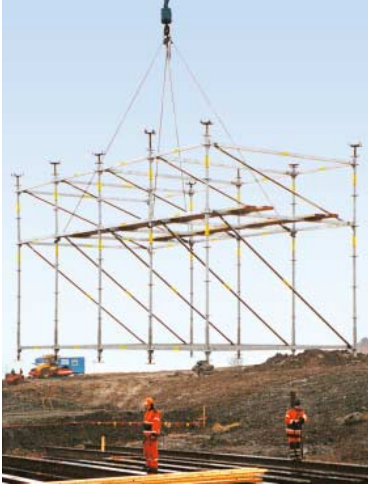
Sollevamento di un'unità premontata, mediante gru.
