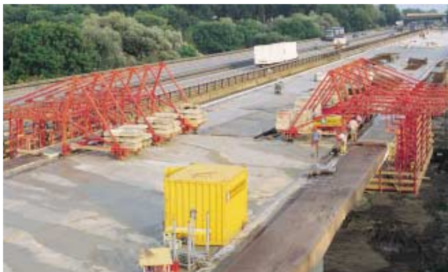
Incastellature traslabili accoppiate PERI GKW per "cordoli" consente di spostare in modo semplice e veloce unità di grande dimensione. La fotografia mostra due unità GKW di circa 15 m.
