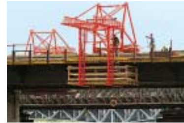
Efficiente e sicuro: l'incastellatura traslabile di serie PERI GWK per marciapiedi/cordoli.
