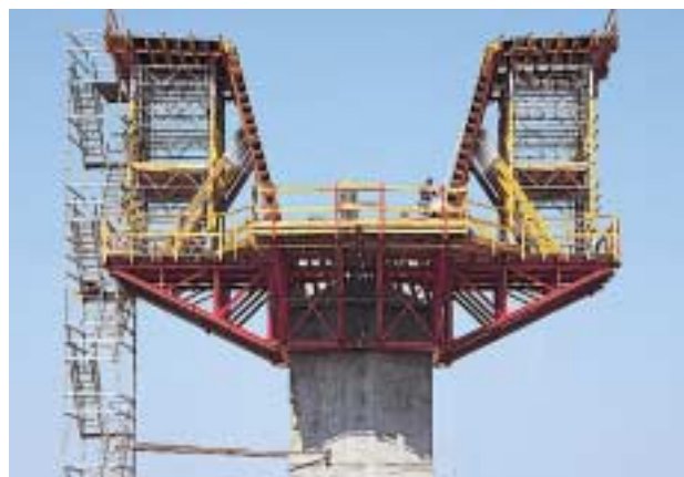
Posizionamento della cassaforma della testa pila (pulvino) con piattaforma a sbalzo. Sono evidenti le dimensioni esterne notevoli della sezione della trave scatolare dell'impalcato.
