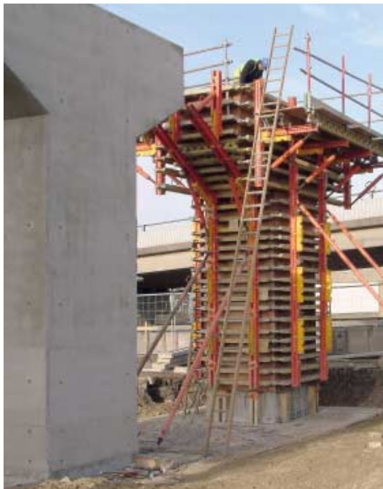
Pile monolitiche con e senza cassaforma.
