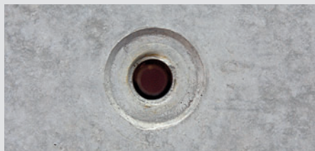
Foro per il passaggio del tirante MX.
