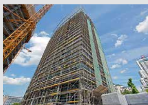
Ponteggi di facciata
