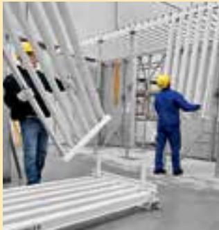
... ruotarlo verso l'alto con l'asta di montaggio fino a portarlo in posizione orizzontale, poi agganciare il puntello per solai e posizionarlo verticalmente.
