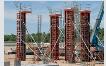
Casseforme per pilastri
