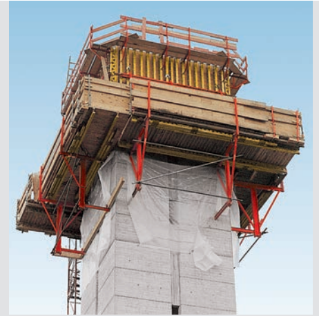
Campanile a Feldmoching, vicino a Monaco di Baviera. VARIO GT 24 abbinato al sistema di ripresa KGF 240.
