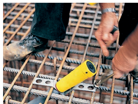
Sistema di ancoraggio fissato ai ferri di armatura semplicemente con filo metallico e pinza.
