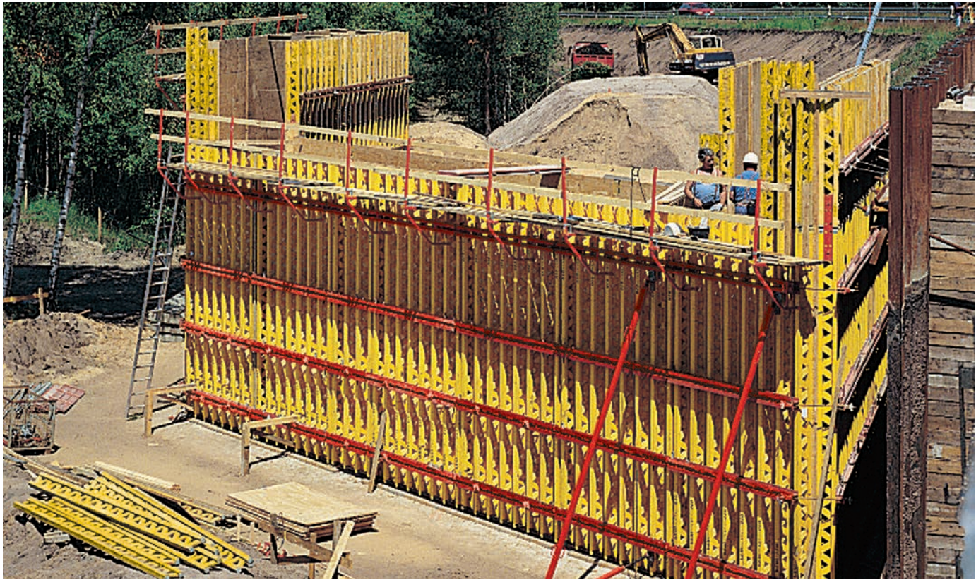
Ponte sul Danubio, autostrada BAB 8 nei pressi di Leipheim.
