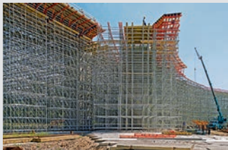
Impalcature di sostegno
