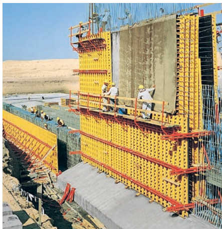
VARIO GT 24 per la realizzazione di un impianto di depurazione con pareti a sezione trapezoidale.
