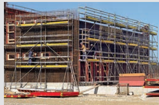
Impalcature di servizio
