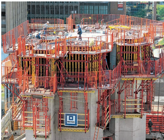
Costruzione di un edificio multipiano a Parigi con VARIO GT 24 e il sistema di ripresa CB 240.
