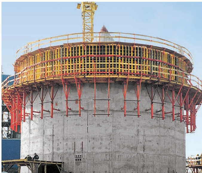
VARIO GT 24 per la realizzazione di un serbatoio. Per ottenere la forma circolare sono stati inseriti spessori in legno tra le travi ed i correnti.
