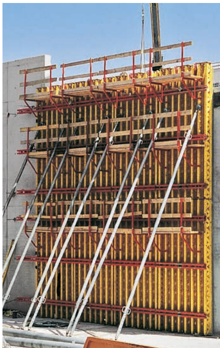
Moduli VARIO GT 24 sovrapposti, impiegati per la realizzazione di un edificio adibito ad uffici.
