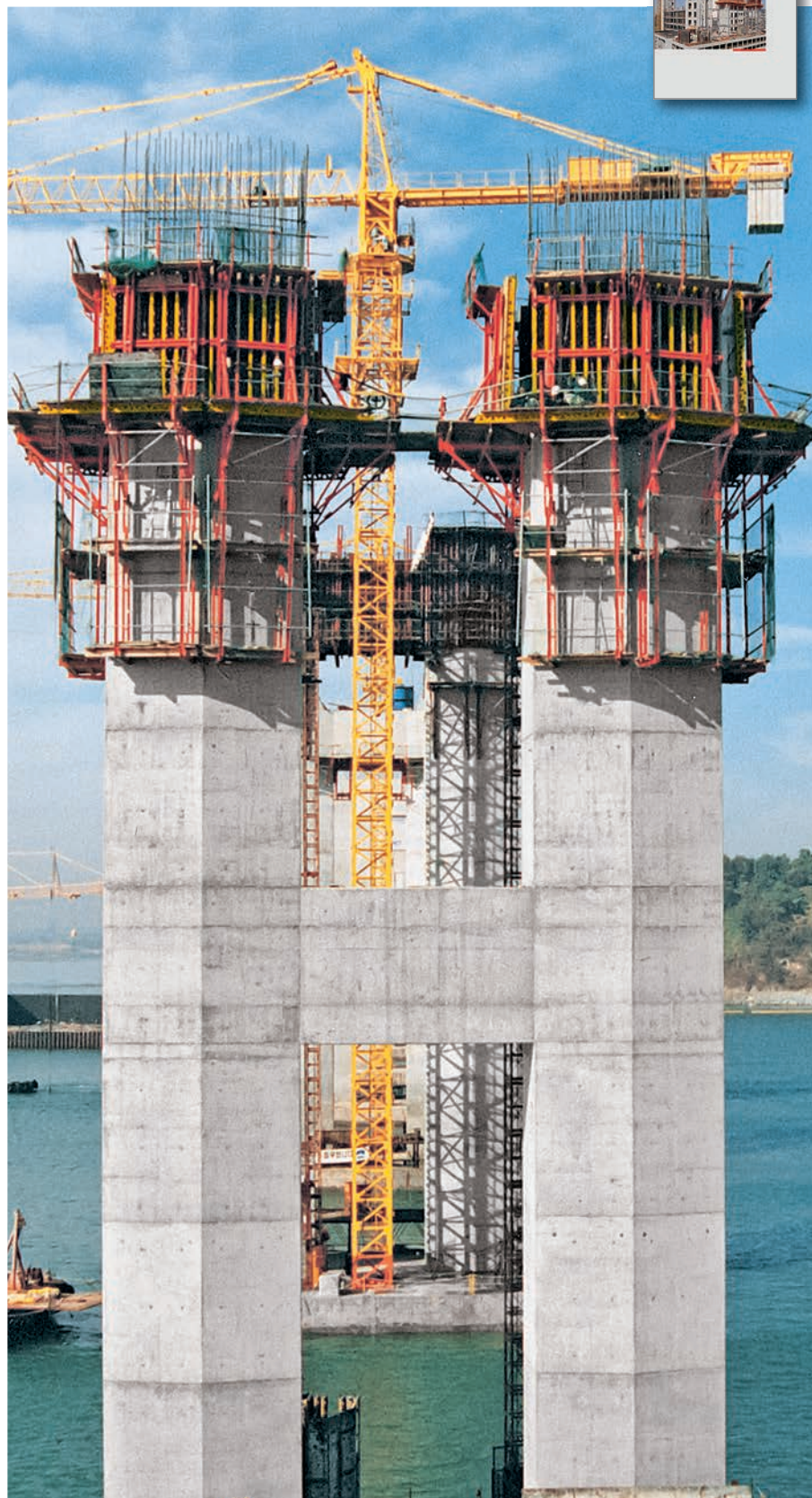
CB 240, il sistema di ripresa che consente di operare in modo agevole davanti e dietro la cassaforma.
