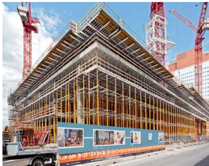
Lavorare in sicurezza lungo i bordi liberi dei solai
