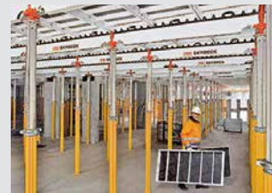
Casseforme per solai
