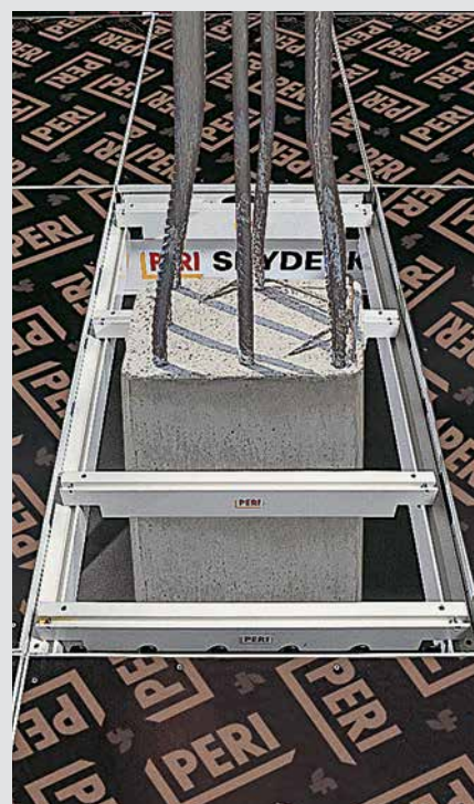
Se utilizzate sia in senso longitudinale che trasversale, le orditure di adattamento devono essere capovolte.
