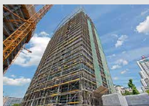
Ponteggi di facciata
