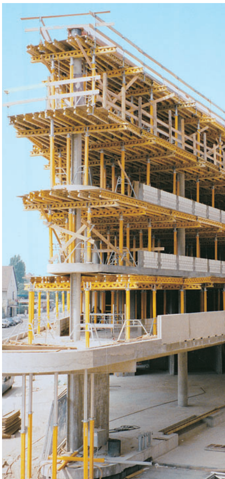
Quando le fasi d'impiego della cassaforma sono più rapide dei tempi minimi di disarmo.
