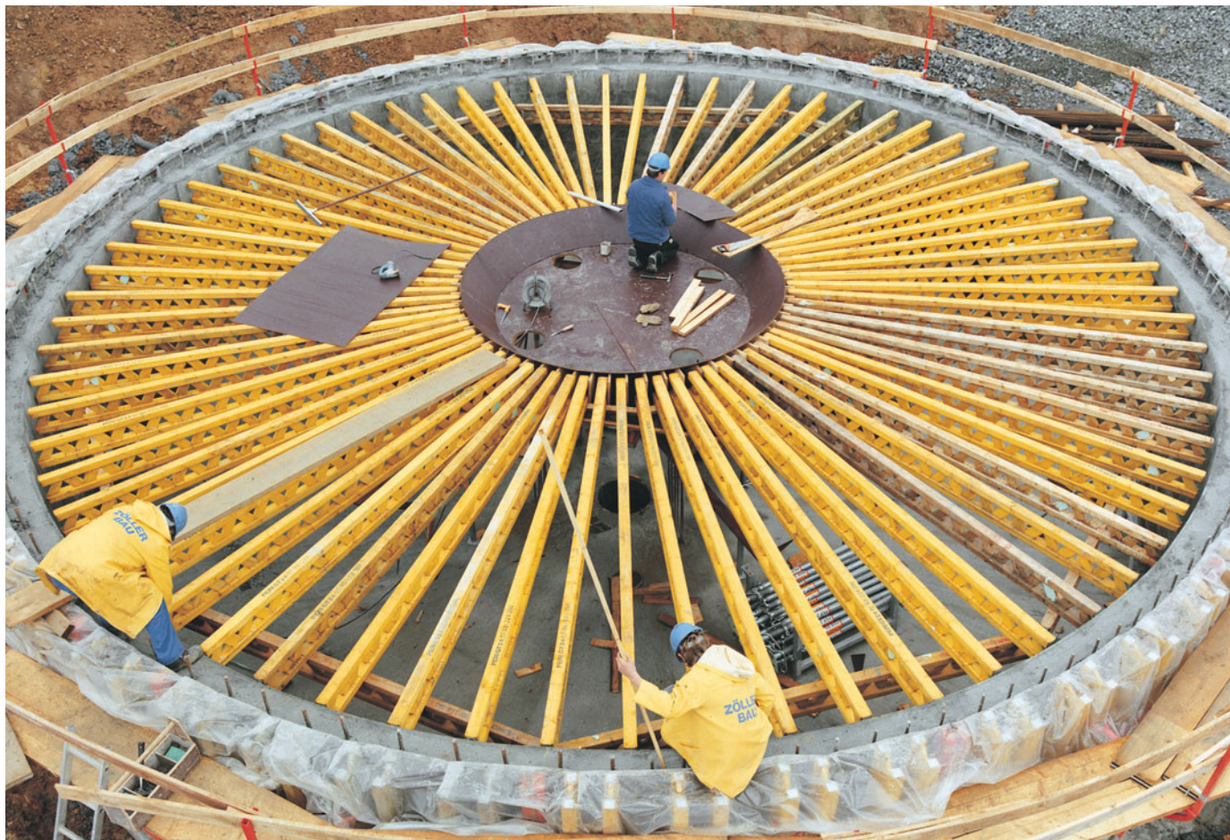
La cassaforma MULTIFLEX con GT 24 utilizzata per un serbatoio cilindrico con diametro di 11,60 m e con soletta di copertura tronco-conica.
