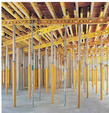
Variando la direzione delle travi di orditura primaria ed accostando le travi di orditura secondaria è possibile adattare la cassaforma MULTIFLEX alle diverse configurazioni.
