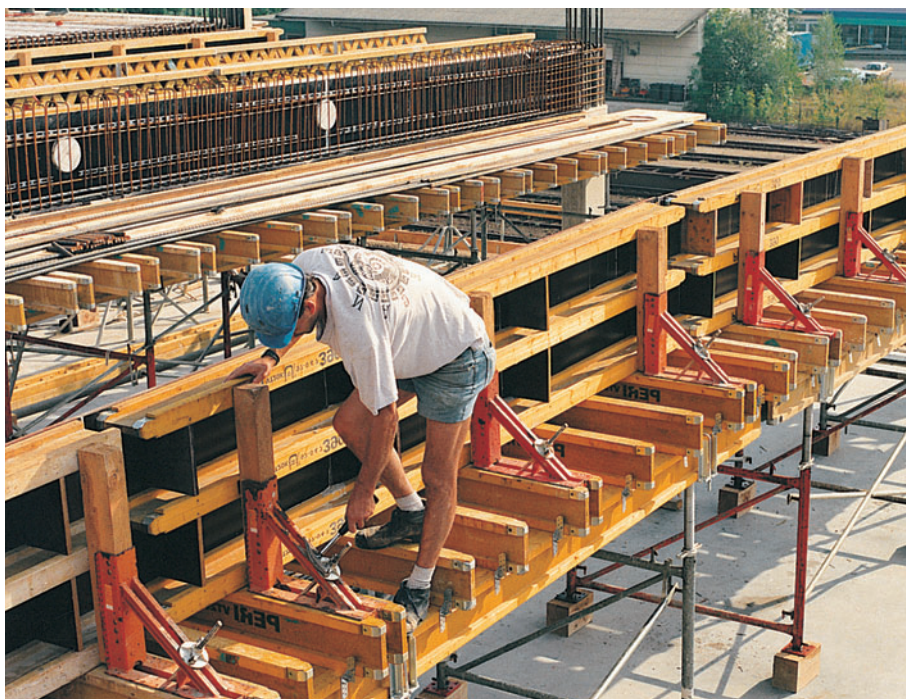
Tavoli PERI PD 8 con telai-piedritti PERI UZ, utilizzati per la costruzione di un parcheggio.
