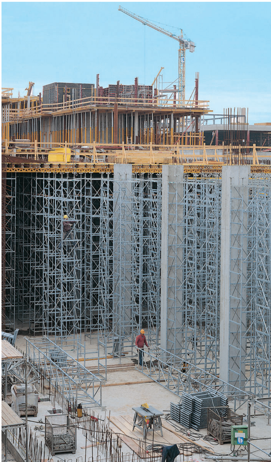
Il preassemblaggio dell'impalcatura a torre di sostegno ST 100 può essere effettuato su un piano di lavoro calpestabile.
