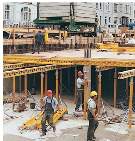
Costruzione di un parcheggio interrato: coppie di GT 24 come orditura primaria e montanti MULTIPROP per sopportare carichi elevati. Si riducono così i tempi della cassaforma.
