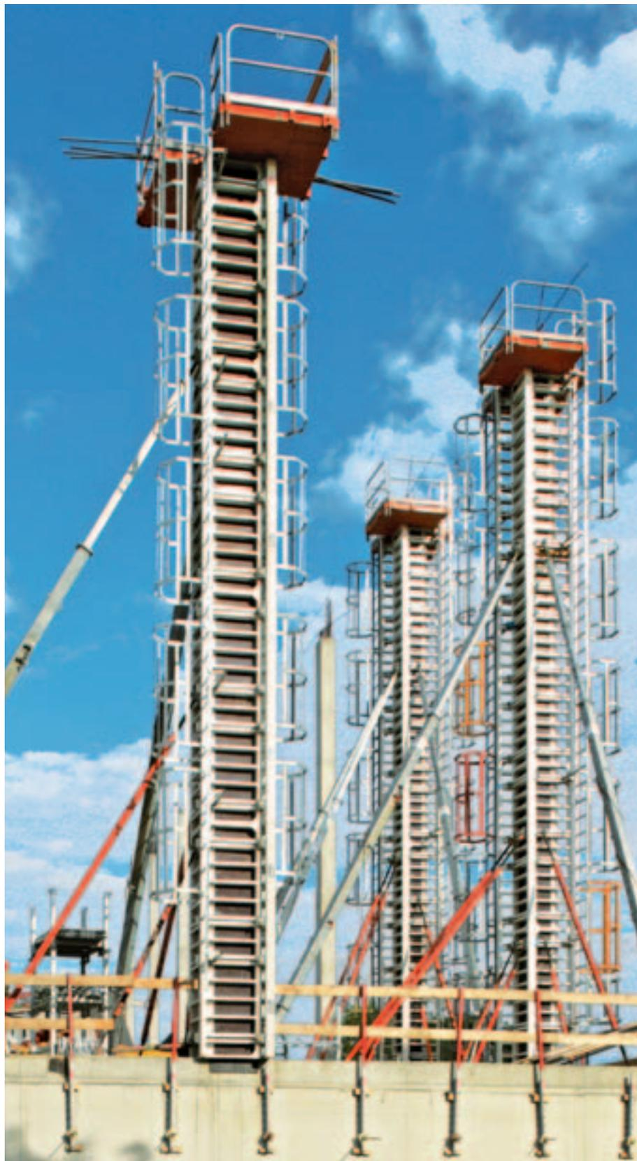
Cassaforma per pilastri PERI RAPID completa di scale d'accesso e piattaforma di servizio.
