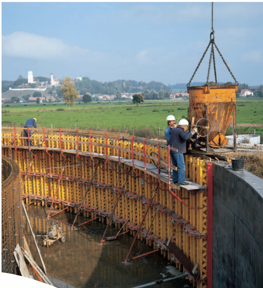
Cassaforma RUNDFLEX, per differenti raggi di curvatura, con un'altezza di 3,60 m per la costruzione di un impianto di depurazione.
